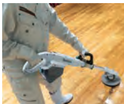
Limpieza y eliminación con cera de resina
